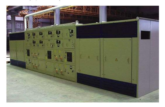
**КТПВ - комплектные трансформаторные подстанции внутренней установки мощностью 250...2500 кВА** предназначены для приема, преобразования и распределения электроэнергии по потребителям. КТП классифицируются
